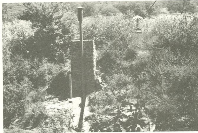
ESTACION EL COLORADO SOBRE EL RIO EL COLORADO El limnógrafo y la escala, en la margen derecha.
