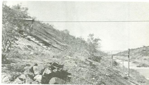
ESTACION VERTEDOR PRESA MELCHOR OCAMPO SOBRE EL CANAL VERTEDOR DE LA PRESA MELCHOR OCAMPO
