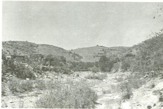
ESTACION LA YERBA BUENA SOBRE EL ARROYO LA YERBA BUENA Vista de conjunto de la estación, desde aguas abajo.
