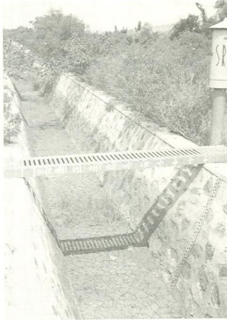
ESTACION ANGAMACUTIRO II SOBRE EL CANAL MARGEN IZQUIERDA La pasarela de aforos y el limnógrafo en la margen derecha
