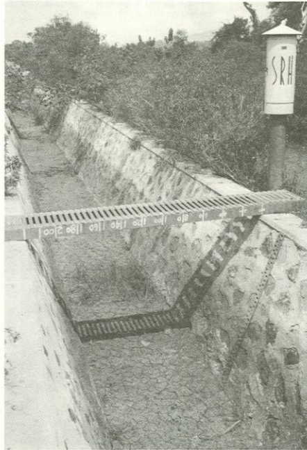
ESTACION ANGAMACUTIRO II SOBRE EL CANAL MARGEN IZQUIERDA La pasarela de aforos y el limnógrafo en la margen derecha
