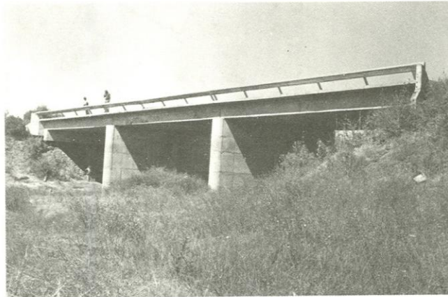
ESTACION ANGAMACUTIRO II SOBRE EL RIO ANGULO (SALIDAS PRESA) Puente carretero que se utiliza como estructura de aforo.
