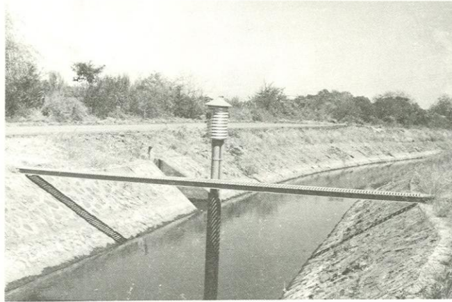
ESTACION ANGAMACUTIRO II SOBRE EL CANAL MARGEN DERECHA La pasarela de aforos y el limnógrafo al centro
